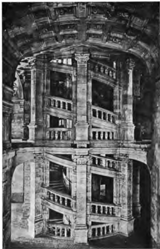
Fig. 108. — Escalier central à deux volées se superposant au château de Chambord. Départs diamétralement opposés. Vue prise au moment de l'enlèvement d'un plancher et laissant voir la cage dans la hauteur de deux étages.
